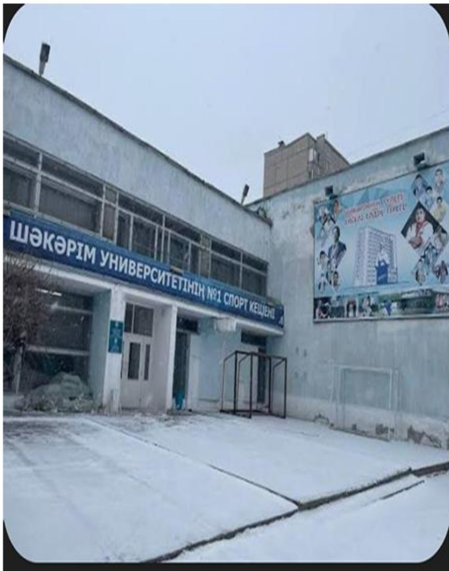
состояние до ремонта
