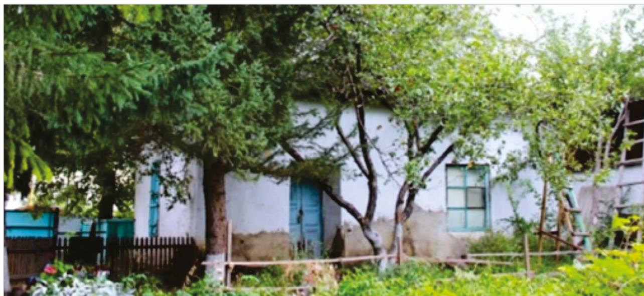
Рис. 2. Современное состояние бывшего дома А. С. Хахлова в Зайсане. Фото С. В. Киселевой, 2024 г.
