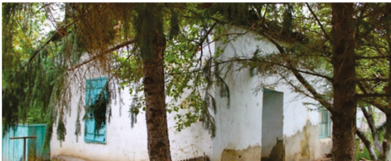
Рис. 3. Современное состояние бывшего дома А. С. Хахлова в Зайсане. Фото С. В. Киселевой, 2024 г.
